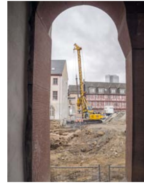
Blick vom Saalhof auf die Baugrube, 26. April 2012. Foto: S. Bund
