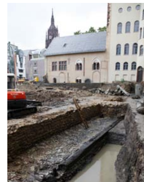
Der staufische Hafenterrass mit Pflasterung und Eichenbalken in der Baugrube. Foto: hmf, U. Dettmar
