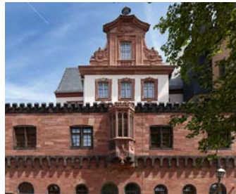
Das Obergeschoss des Zollgebäudes vor dem Westrisalit des Bernusbaus, Mai 2012 (Foto Hochbauamt der Stadt Frankfurt am Main/Joppich & Dörr)
