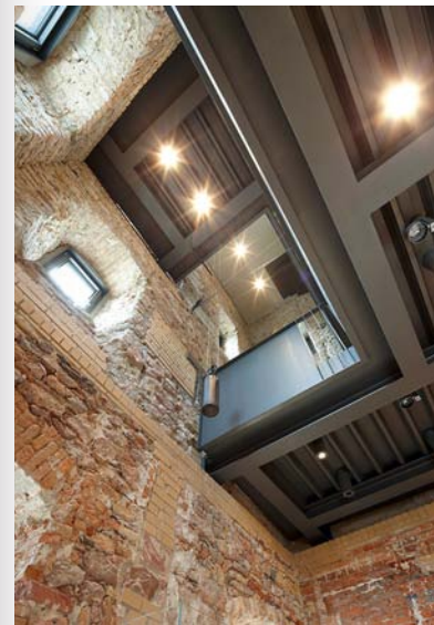
Blick in den Rententurm, vom Erdgeschoss zum zweiten Obergeschoss, Mai 2012 (Foto Hochbauamt der Stadt Frankfurt am Main/Joppich & Dörr)
