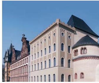
Stauferbau, Burnitzbau und Bernuspalais nach Fertigstellung der Renovierung im April 2012 (Foto hmf/ J. Baumann)
