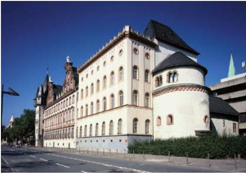
Der "Saalhof" kurz vor der Sanierung im Mai 2009.
