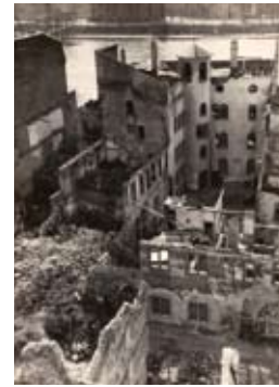
Stauferbau und Burnitzbau nach der Bombardierung vom März 1944; anonyme Fotografie (hmf Ph 1498)
